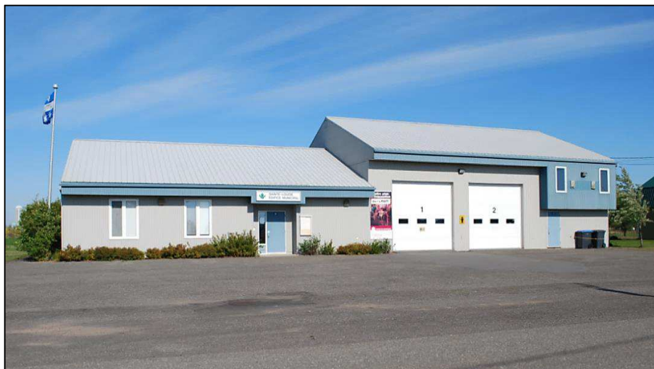
Photo 26. Bureau municipal et service incendie (route de la Station)
