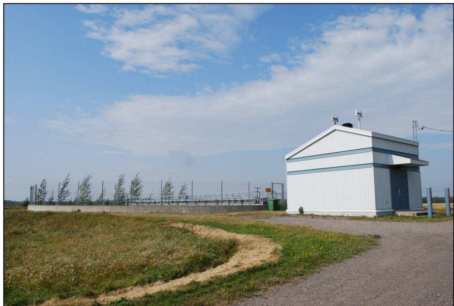
Photo 10. Station d'épuration de type étang aéré (3 e Rang Ouest)
